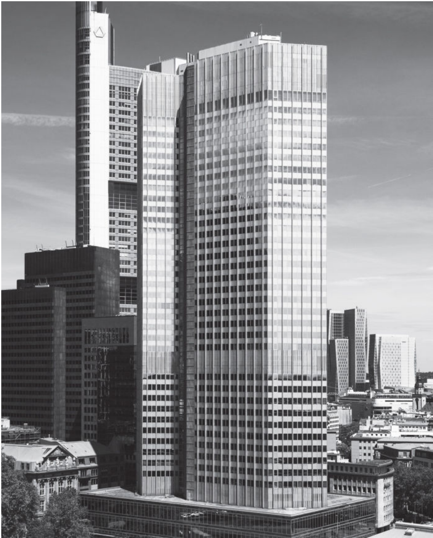
Europese Centrale Bank, Frankfurt
