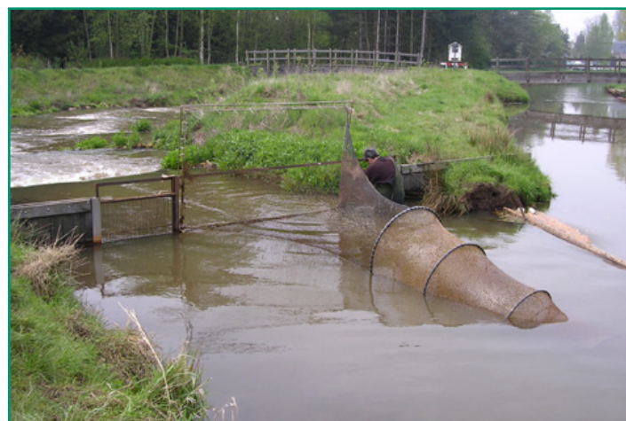
Figuur 3: Installatie van de vistrapfui aan de bekkenvistrap in de Kleine Nete in Herentals. Rechts onder de brug ligt een onoverbrugbare stuw. Via de vistrap links kunnen vissen de stuw toch passeren.
