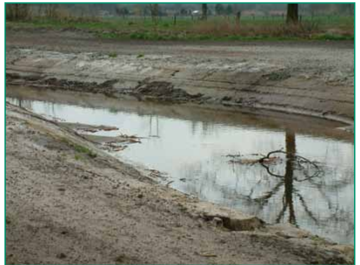
Figuur 4: Slib en rietrhizomen uit de oude loop werden in de oeverzone van de nieuwe beekloop gebracht © Willy Cools
