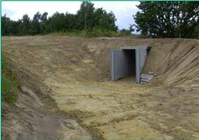
Figuur 3: Tunnelconstructie in opbouw (zomer 2012) voor de vleermuizen in Fort van Duffel © Kempens Landschap
