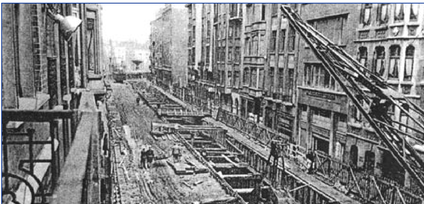
Zelfregeringsstraat, werken van de omlegging en de tweede overwelving van de Zenne, 1931-1955. (Archiefphoto - Collectie Intercommunale van de Zenne)
