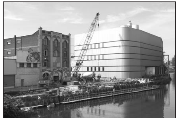
Werken ter hoogte van de Zeebergbrug in Aalst
