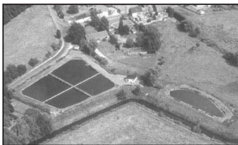
▶ RWZI van Maffle (bron: IPALLE)
