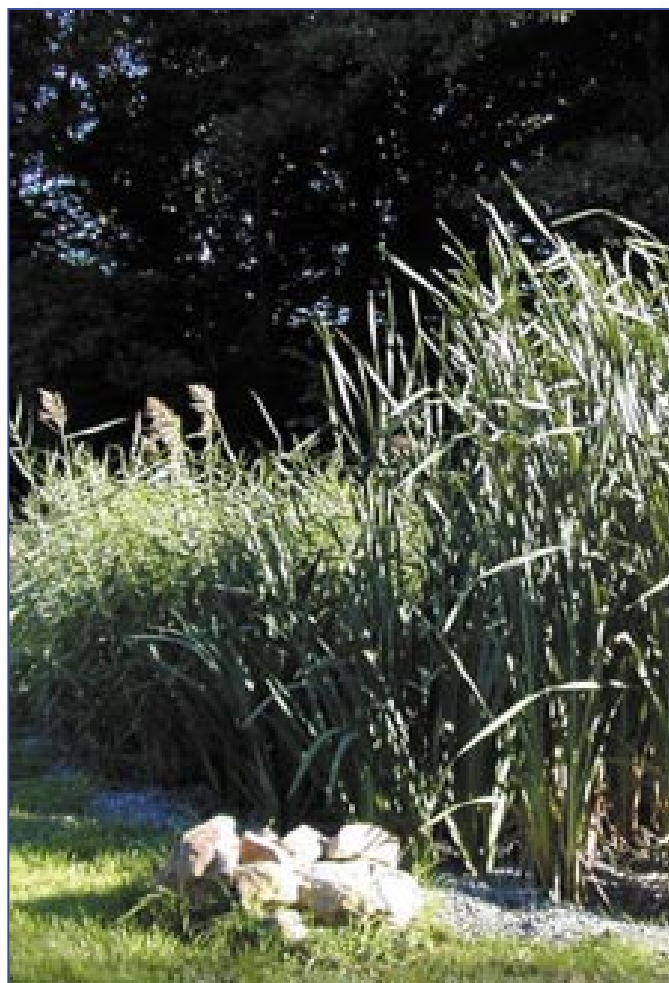
► Waterzuivering aan de hand van een rietveld
