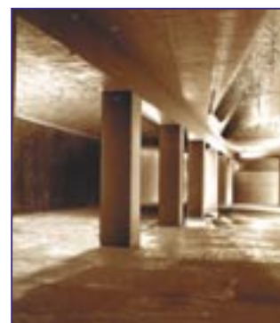
► Weldra een stormbekken in Vorst, gelijkaardig aan dat van de Rodebeek
