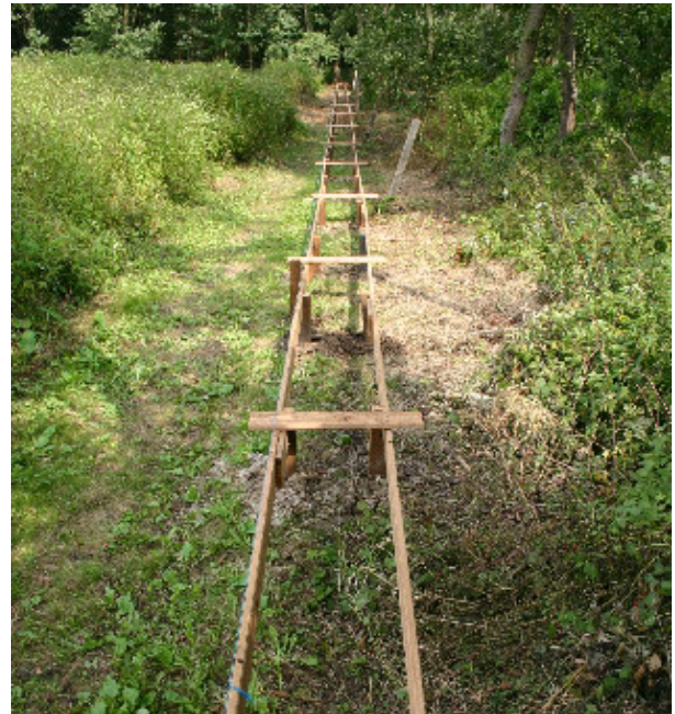
Het knuppelpad in aanleg
