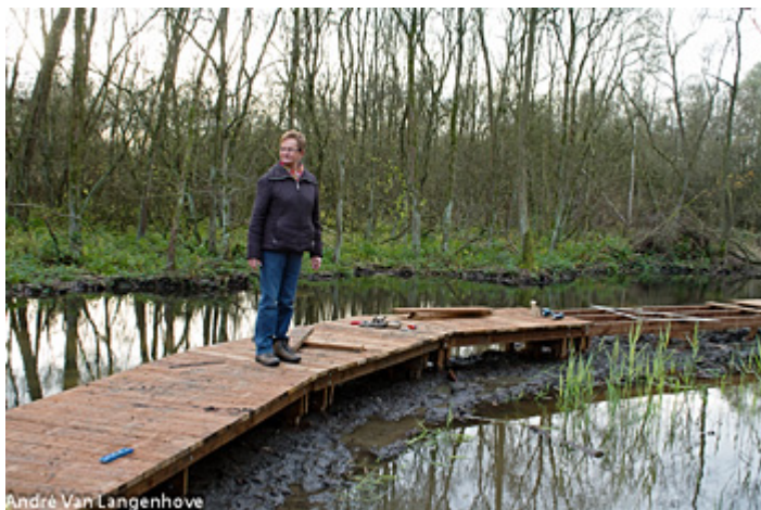
Nieuw knuppelpad in aanbouw
