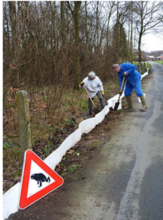
Plaatsen paddenschermen Doornlaarlei Rumst
