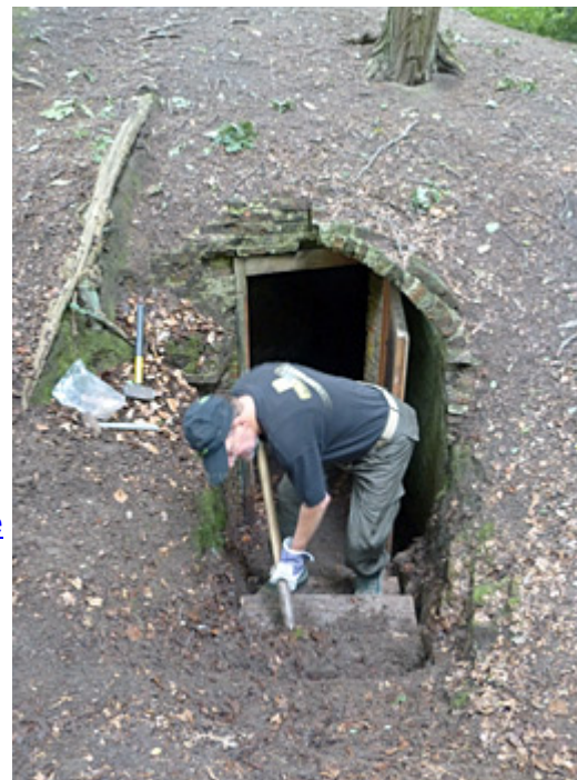
Plaatsen bielzentrap ijskelder Hof ten Eiken
