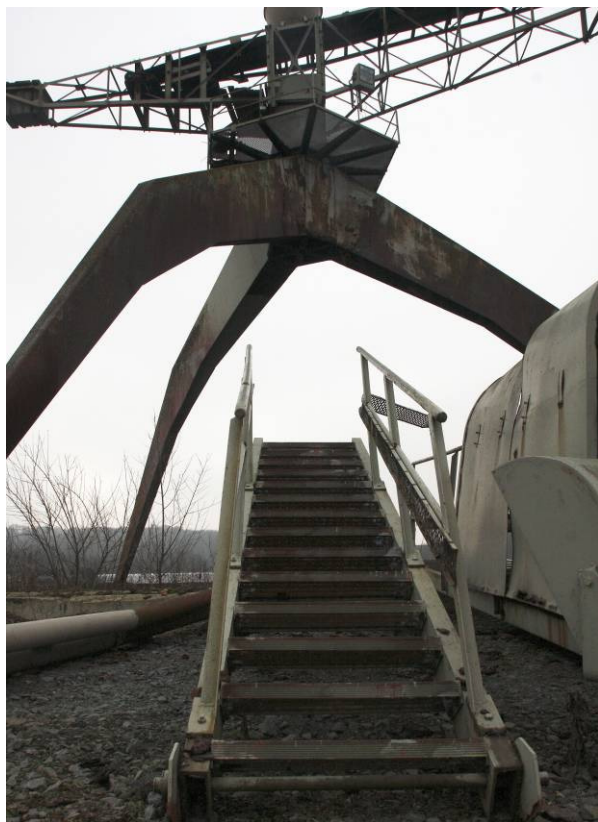
Verdeelinstallatie voor het stockeren van houtsnippers en een gedeeltelijk behouden transportband van het voormalig bedrijf UNAL, heden terrein van NV Van Israel te Geraardsbergen. Zie verder blz. 29 onder Geraardsbergen, Foto: SIWE vzw
