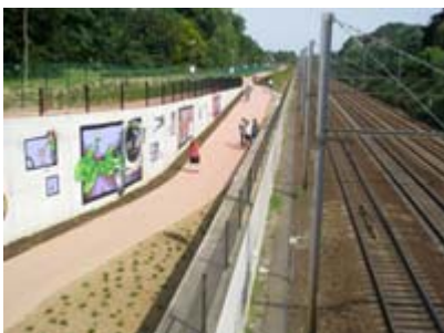
Nieuwe fietstunnel Hove
