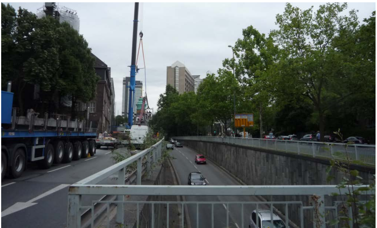
La L448 traverse de part en part le centre-ville d'Essen, dans la Ruhr en Allemagne, qui est essentiellement piéton. Voie rapide à grand trafic, empruntant de nombreuses trémies pour éviter des carrefours de plain-pied et des bâtiments patrimoniaux, la L448 constitue une vraie coupure dans la trame urbaine, séparant, de fait, en deux morceaux distincts, le centre-ville.
