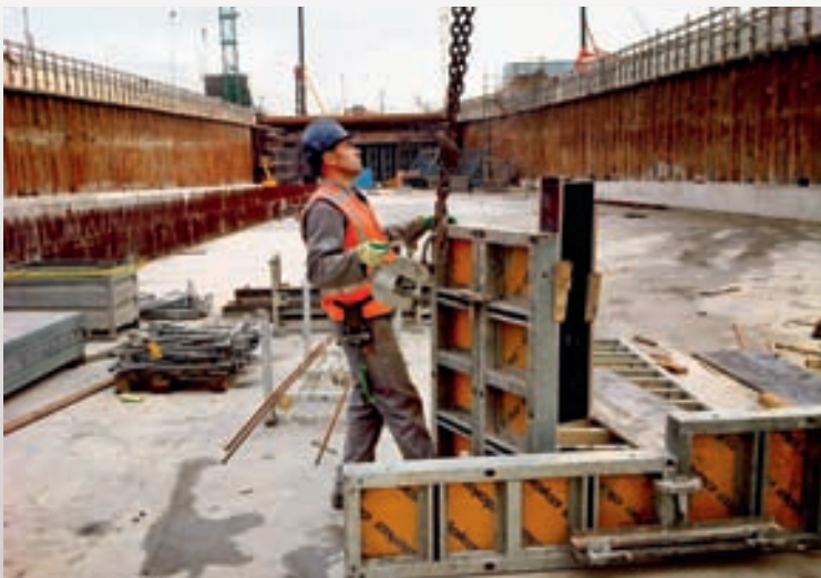
■ In de bouw blijft de oude discriminatie tussen arbeiders en bedienden bestaan en komt er nog een discriminatie bij tussen werfarbeiders en arbeiders in ateliers.
