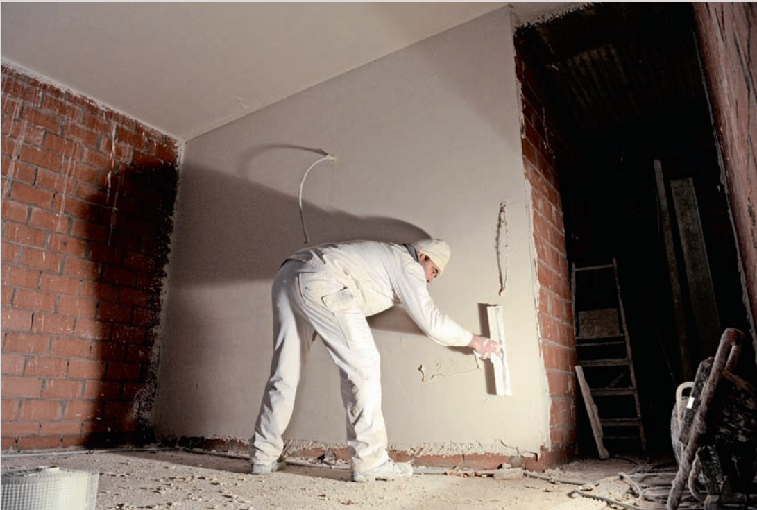
■ Met langere werkweken doe je niets aan het banenverlies in de bouw. Daarvoor is een doeltreffende controle op zwartwerk nodig. Zowel op het Belgische als op het Europese niveau.
