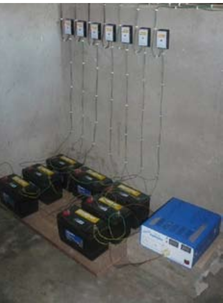
Het zonnepaneel dat zorgt voor electriciteit voor de waterpomp ... en hoe de electriciteit opgeslagen wordt.
