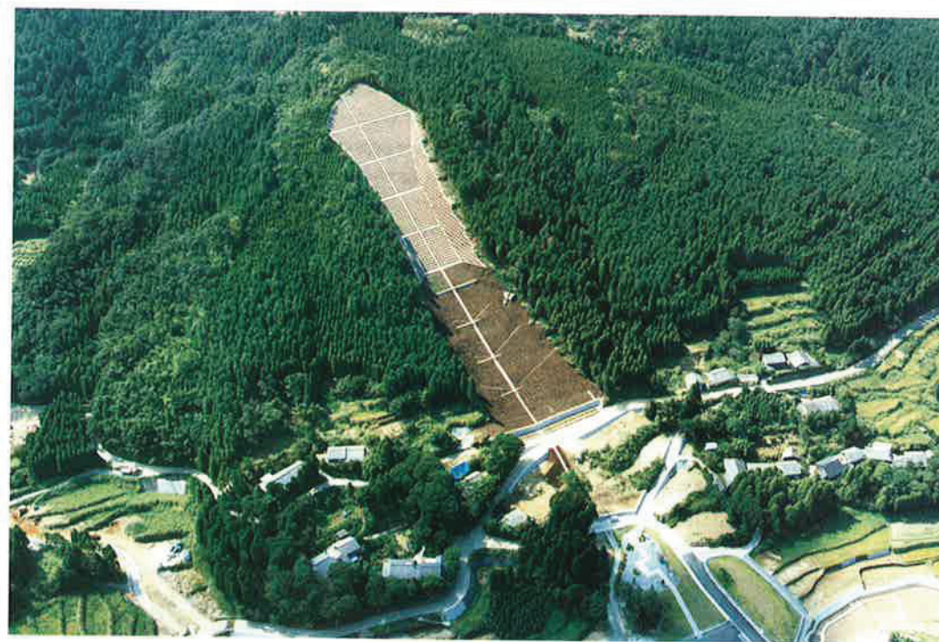
Herstellingswerken aan gedegradeerde hellingbossen
