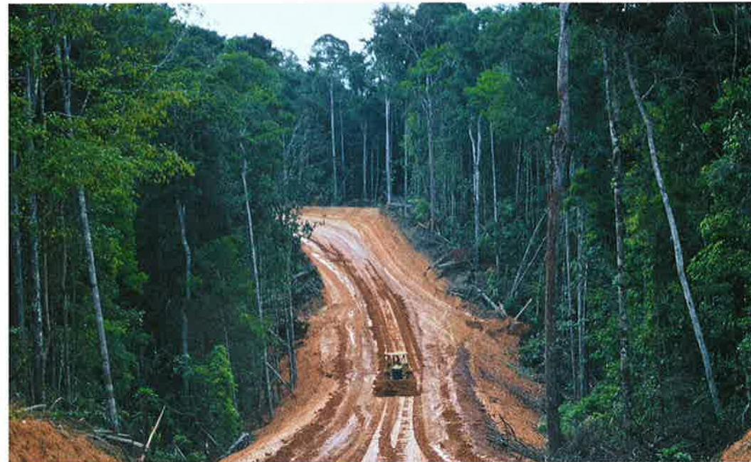
Ontsluitingsweg in de tropen (foto: Edward Parker).
