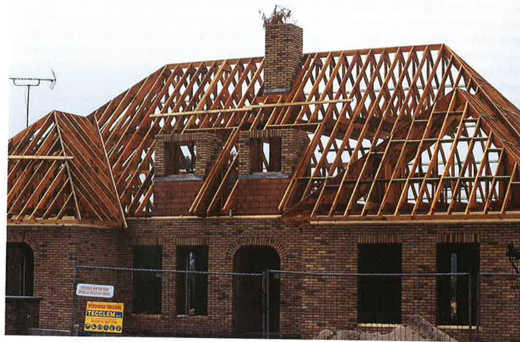
Oprichtmei bij de bouw van een nieuw huis, eigen foto, Overmere, 2002 (foto: Rik De Vreese)
