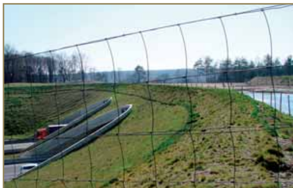
Een ecoduct van boven bekeken: beneden zoekt het verkeer voorbij, terwijl het wild door de draad de goede kant wordt uit geleid.
