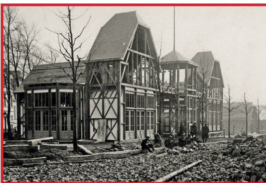
Zoals vele andere paviljoenen op de tentoonstelling werd ook dat van Vooruit opgebouwd met behulp van een techniek waarbij een houten of stalen geraamte bekleed werd met pleister. (Stad Gent, De Zwarte Doos, Stadsarchief)
