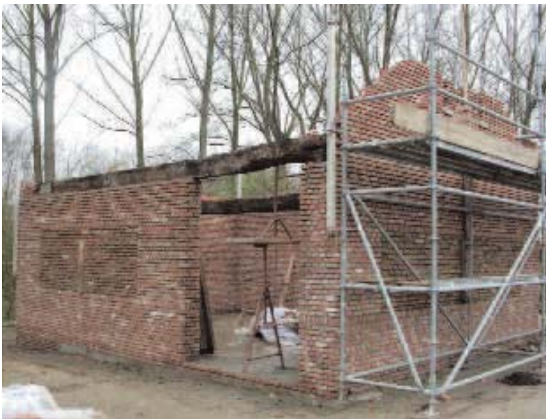
wordt Het grootste deel van de Schaapstal heropgebouwd met een nieuwe Oud-Brabantse handgevormde gevelsteen. Foto Geert Braem
