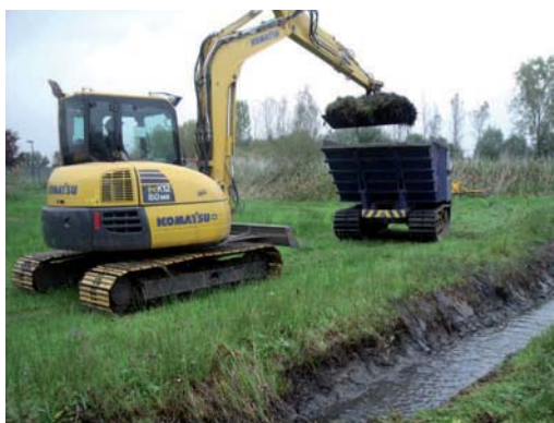
Voor de ontmoddering van de sloten in de vochtige veengraslanden aan het Donkmeer werden licht graafmateriaal en dumpers op rupsbanden gebruikt om de schade aan de kwetsbare hooilandvegetatie tot een minimum te beperken.
