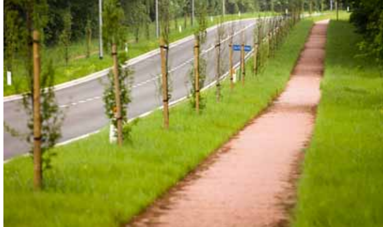
De Lummenseweg (N717) tussen Lummen en Beringen: een veilig van de rijbaan afgescheiden fietspad met verharding in cementbeton.
