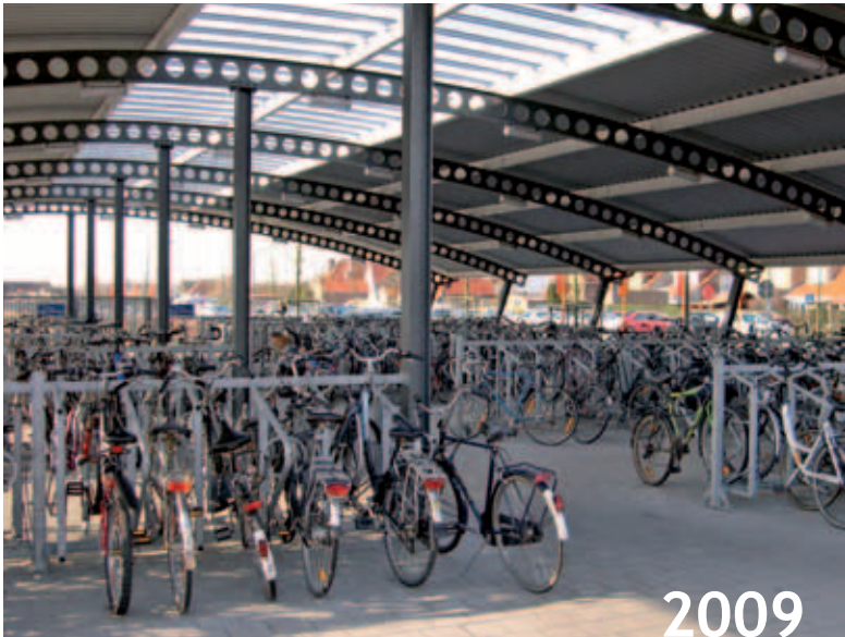
Station NMBS Knokke Een overdekte en open fietsenstalling met veel natuurlijk licht langs het dak en de zijanten. De fietsenstalling staat vlakbij het station en wordt ’s avonds verlicht met kunstlicht. Fietsen kunnen met het kader vastgemaakt worden aan de beugels. Een minpunt is de beperkte ruimte tussen de fietsen: niet echt comfortabel en fietslichten en kabels raken daardoor gemakkelijk beschadigd.
