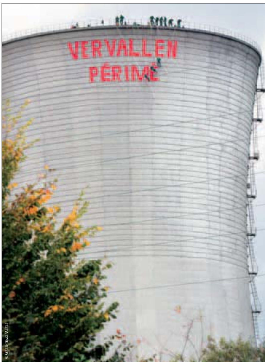
Actie tegen de steenkoolcentrale van Ruien.
