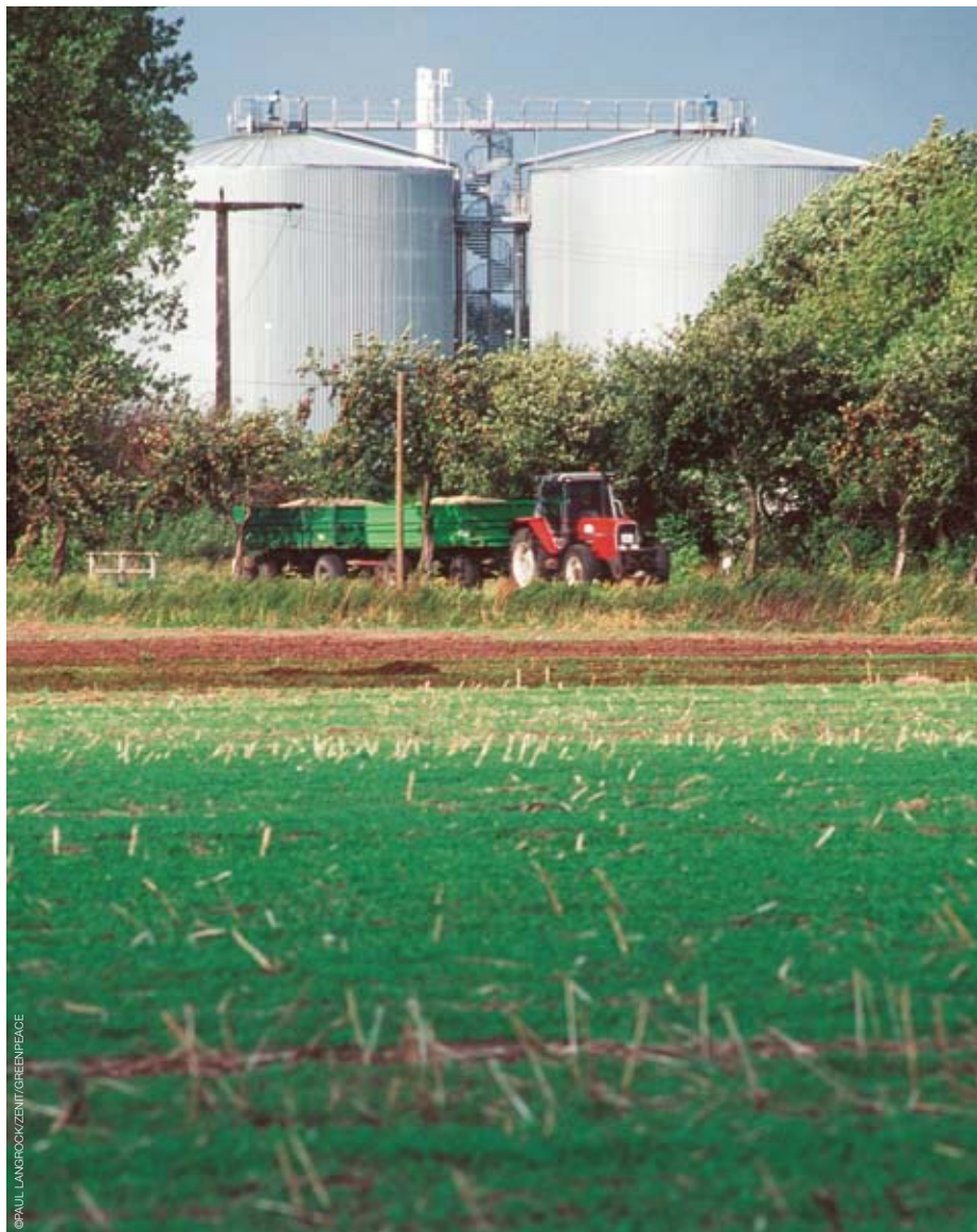
Installatie op biomassa in Dresden, Duitsland.
