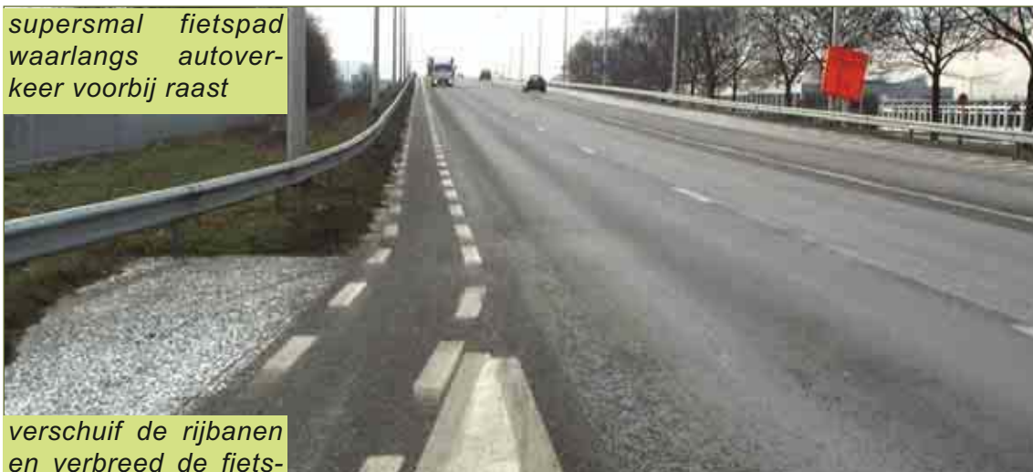
vernieuwd kruispunt ; zelfs hier op de N70 mochten de nieuwe fietspaden toch iets breder zijn : 2.20 m is aange- wezen op zo'n belangrijke route.
