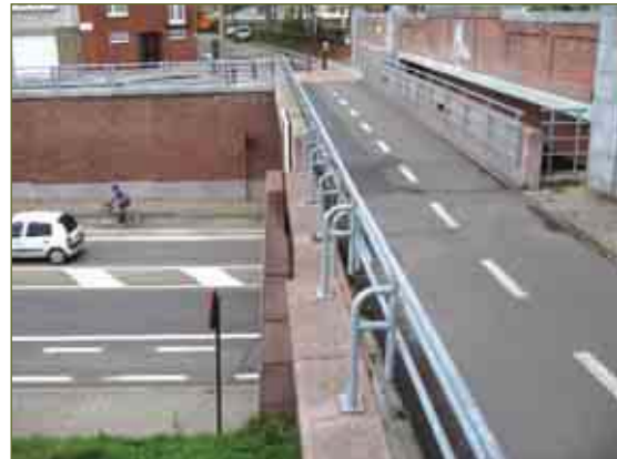
Dergelijke fietsbruggen laten een veilige overstek toe (Kortrijk) ...
