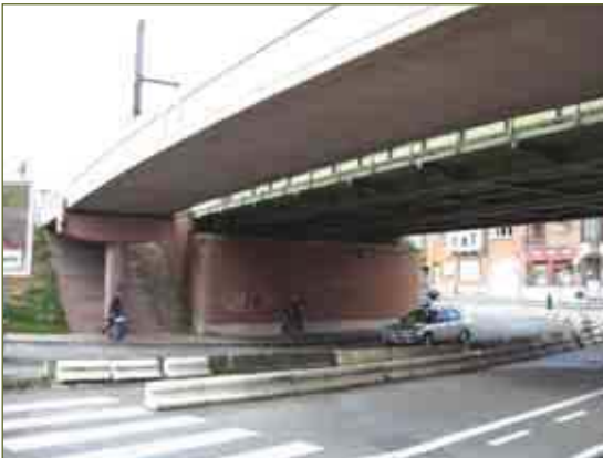
In Kortrijk bouwde men een aparte fietsbrug naast de spoorbrug, hier ter hoogte van de Zwevegensepoort.
