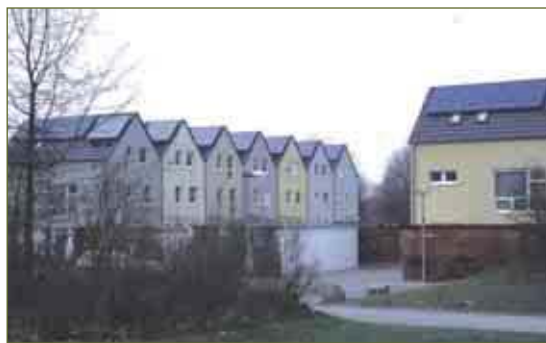
Ook sociale wijken kunnen een duurzaam karakter hebben door een maximale isolatie en het installeren van zonnepanelen zoals hier in Bismarck (Erik Rombaut)
