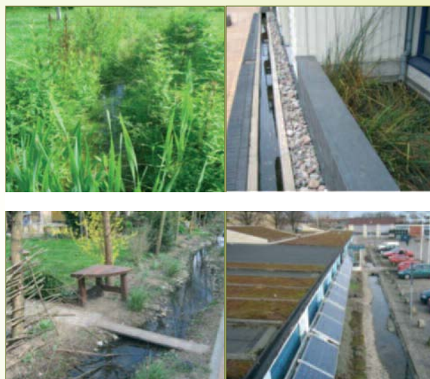
Fig. 7 Wadi's in de wijken [ Water Afvoer Door Infiltratie ]
