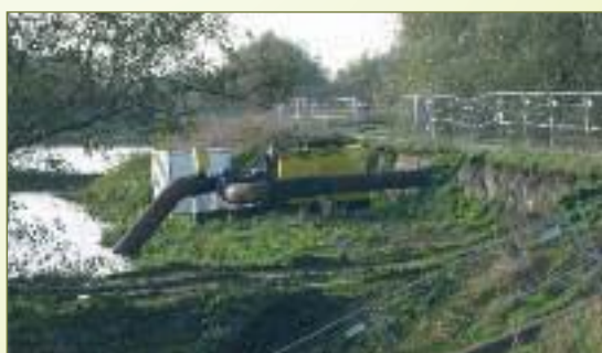
Wanneer het zand is bezonken, pompt men het overtollige water met een krachtige pomp doorheen de Durmedijk terug in de rivier.
