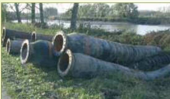
Voor het transport van de baggerspecie in de Durme gebruikt men flexibele buizen die met een metalen kraag aan elkaar gemonteerd worden. Op die manier bekomt men een flexibel, drijvend transportsysteem.
