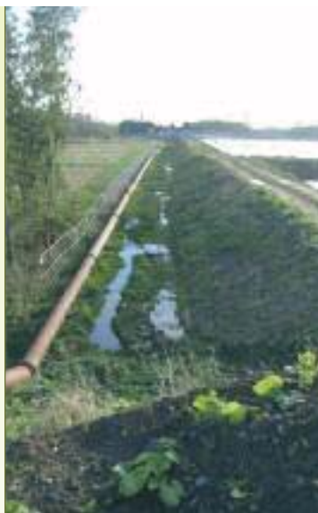
Op land volstaan de gewone metalen buizen. Door deze pijpleiding wordt de baggerspecie tot achteraan in de zanddepot geleid. De baggerspecie wordt opgespoten in het bekken en men laat daar het zand bezinken.
