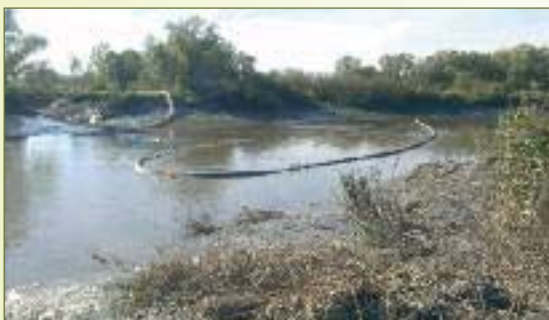
De baggerspecie wordt door het schip opgezogen en via vlottende buizen naar de zandstock in de Bunt (Hamme) gepompt.
