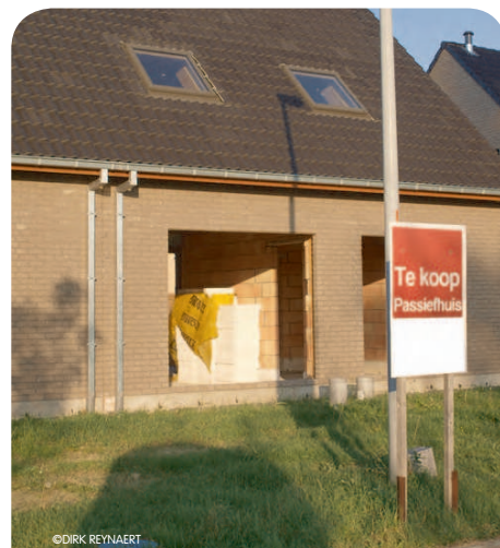
Als bouwpromotoren al passief bouwen, waarom Wevelgem dan niet?
