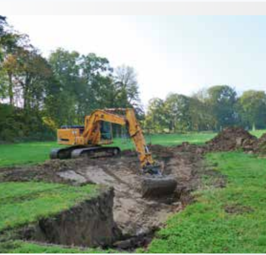
Aanleg van een poel.
