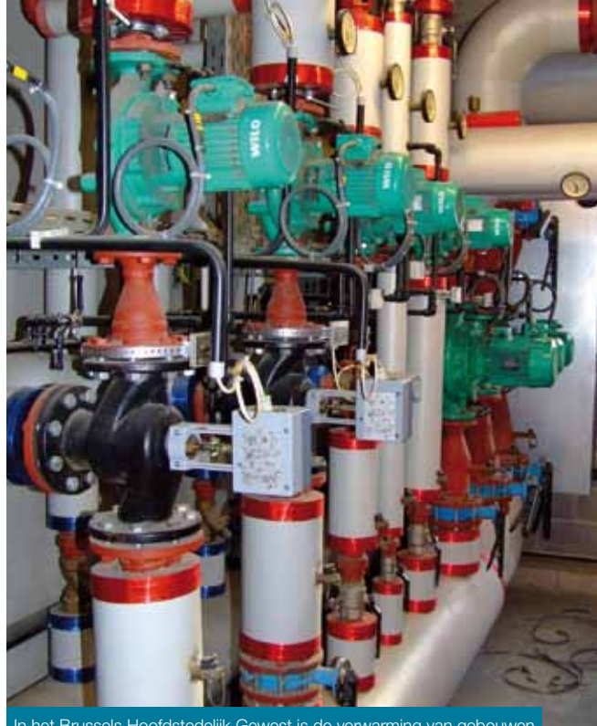
In het Brussels Hoofdstedelijk Gewest is de verwarming van gebouwen verantwoordelijk voor bijna 70 % van de broeikasgasemissies.
