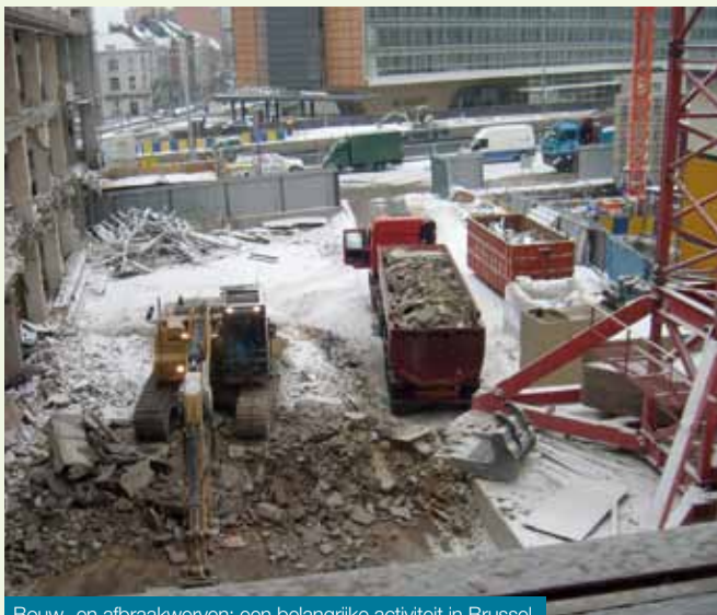
Bouw- en afbraakwerken: een belangrijke activiteit in Brussel.
