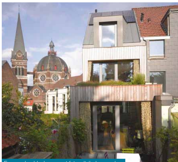
Een voorbeeldgebouw met fotovoltaïsche panelen.
