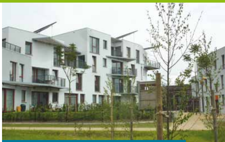
Het BWLKE (COBRACE) bepaalt de nieuwe normen voor duurzaam bouwen.
