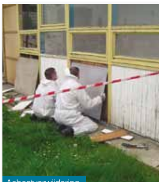
Asbestverwijdering.
