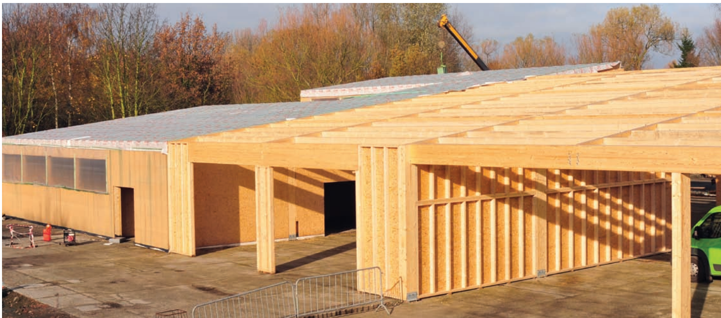
De bouw van de loods is volop bezig. Foto: Willy Ibens
