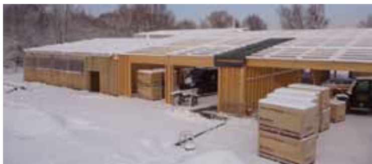
De loods in opbouw
