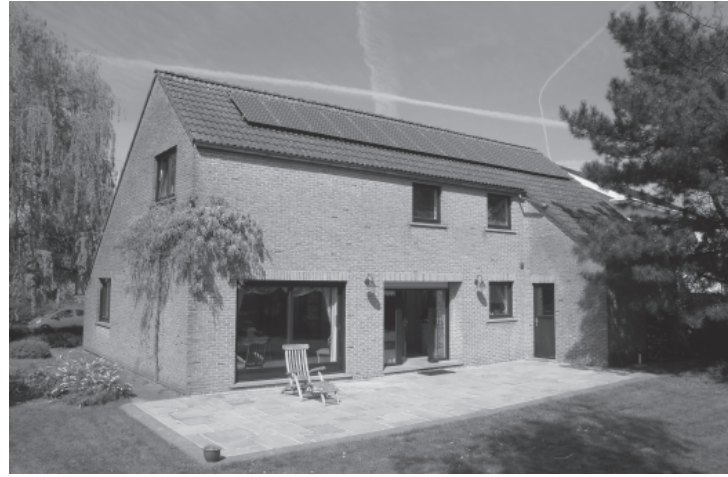
Op dit dak staan al zonnepanelen. Binnenkort ook bij jou? Foto: Guy Leys.
