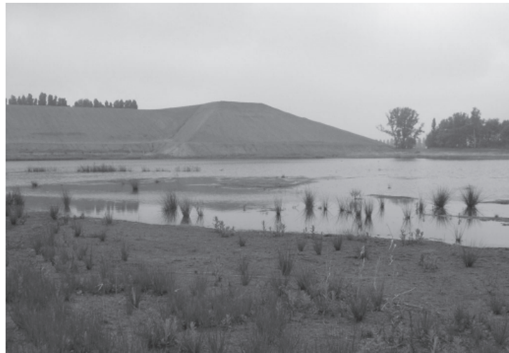
Het uitgegraven zand werd gebruikt om de bufferdijk te verhogen zodat de natuur optimaal kan ontwikkelen. Foto: André D'Hoine.
