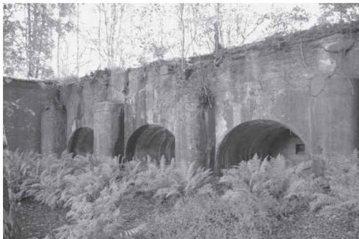
Het Fort van Schoten bestaat uit gemetselde muren, zoals de forten uit de binnenste fortengordel, maar heeft wel betonnen gewelven.
