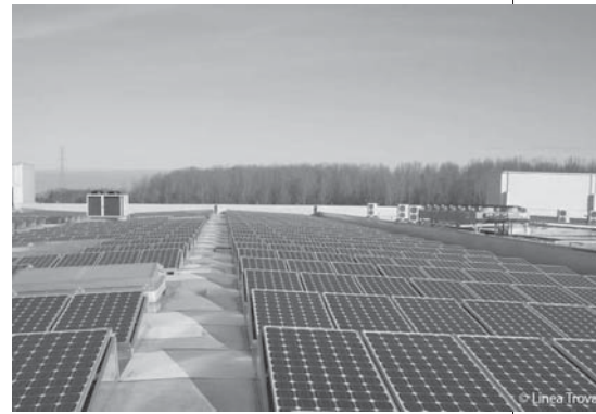
Linea Trovata plaatst zonnepanelen op grote daken zoals dat van de Carrefour in Brugge. Foto: Linea Trovata.
