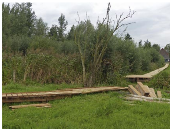
Knuppelpad wordt aangelegd
