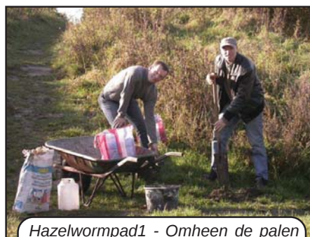
Hazelwormpad1 - Omheen de palen wordt beton gestort
