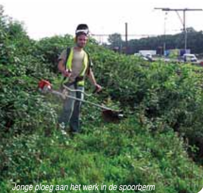
Jonge ploeg aan het werk in de spoorberm
