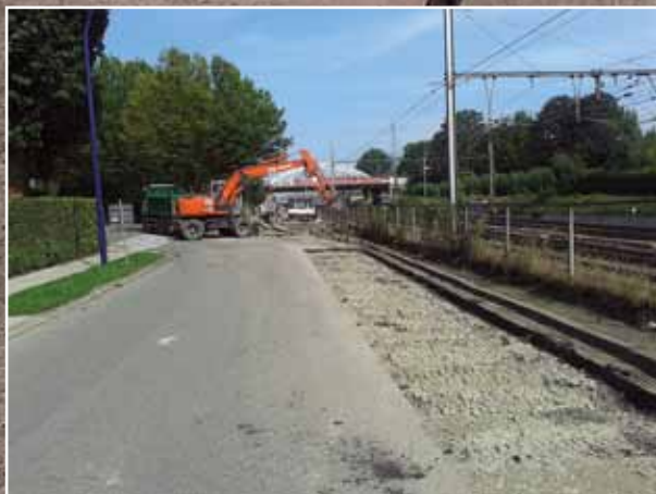
Aanleg fietspad langs Lintsesteenweg in Kontich
