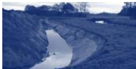
De nieuwe Ellerschans in aanbouw (foto Theo van den Berkmortel)
